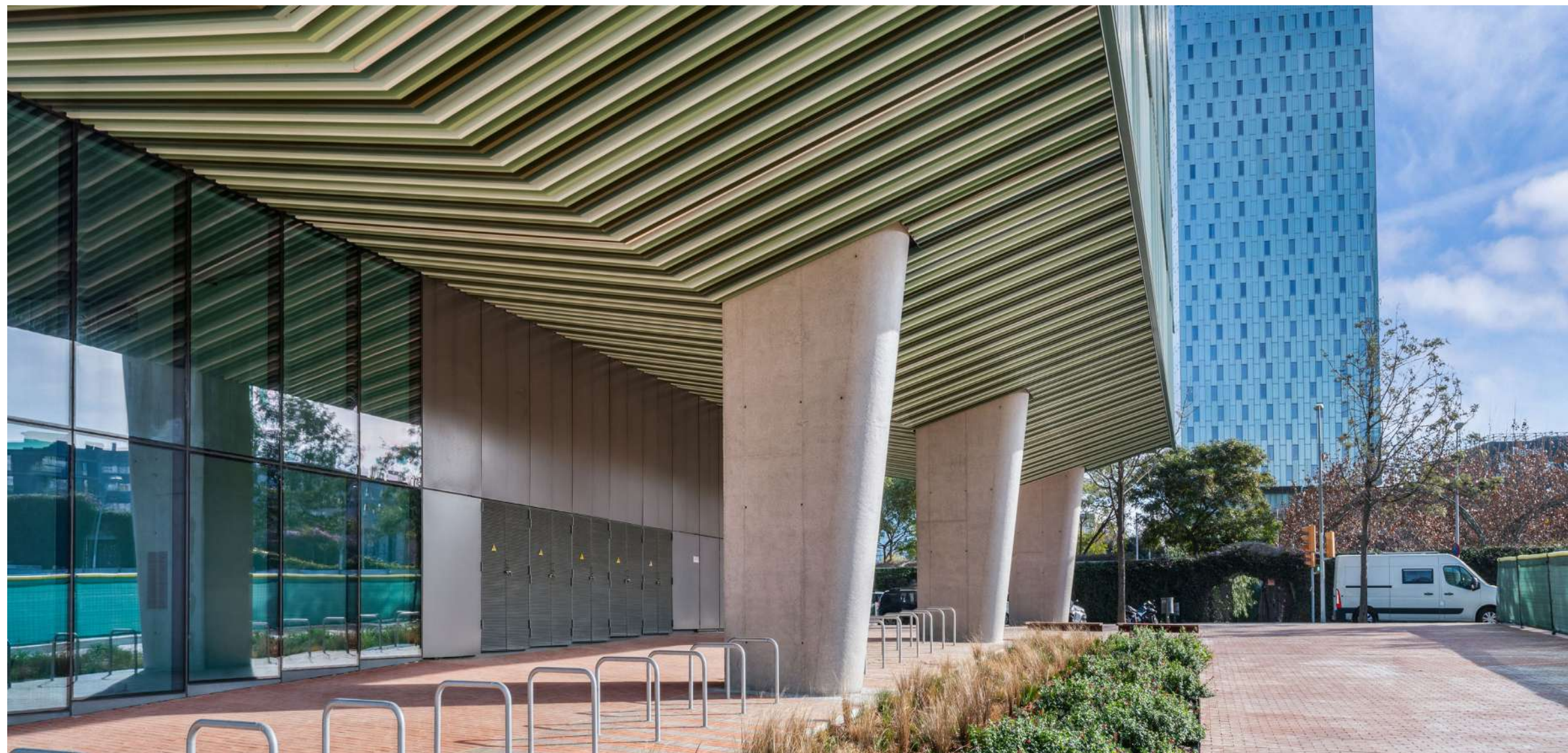
Lobby y parking para bicicletas
