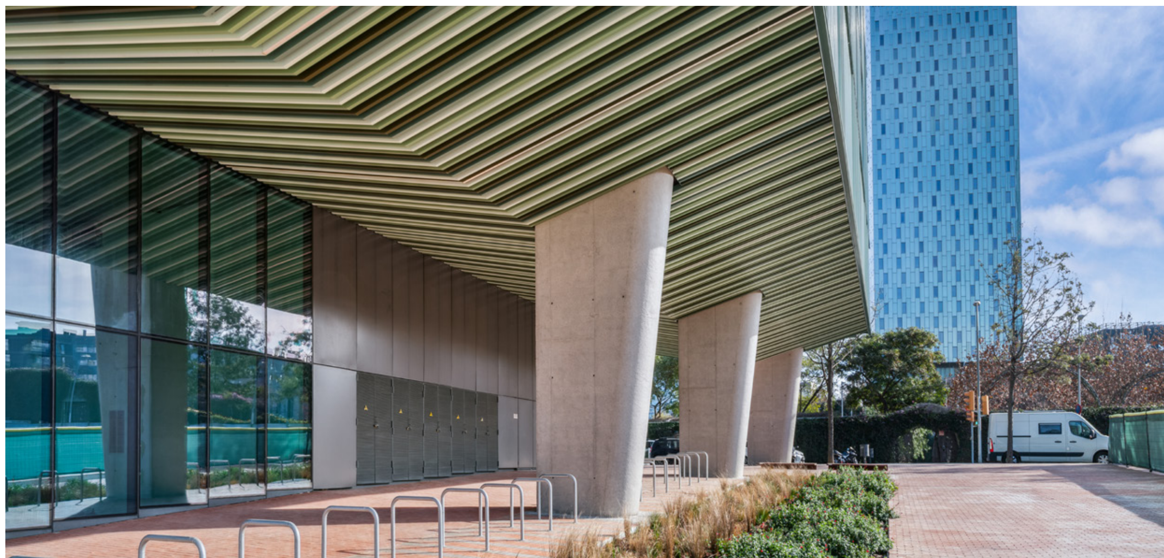
Lobby y parking para bicicletas
